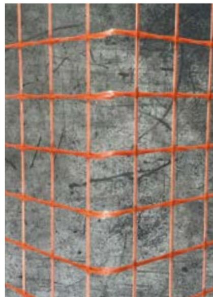
È un angolare a rete in materiale composito (Glass Fiber Reinforced Polymer) alcali resistente. Nello specifico l'angolare GFRP è realizzata da fibra di vetro e resina epossidica.
